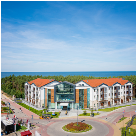
Hotel "Morski Widok". Krynica Morska, Polen
